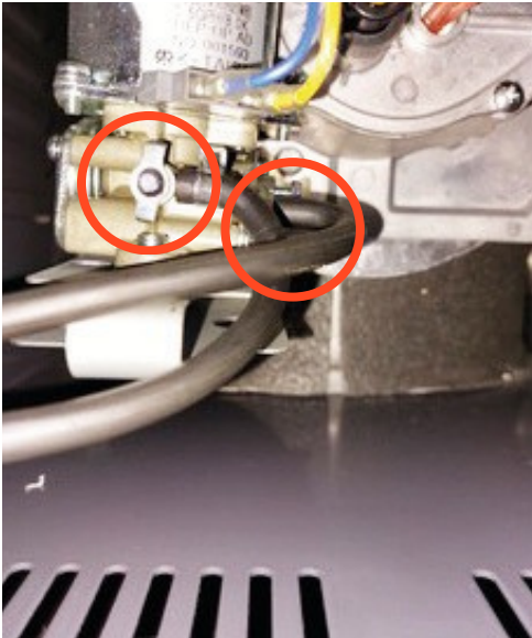
3: Verwijder de brandstofleidingen en haal de brander eraf.
