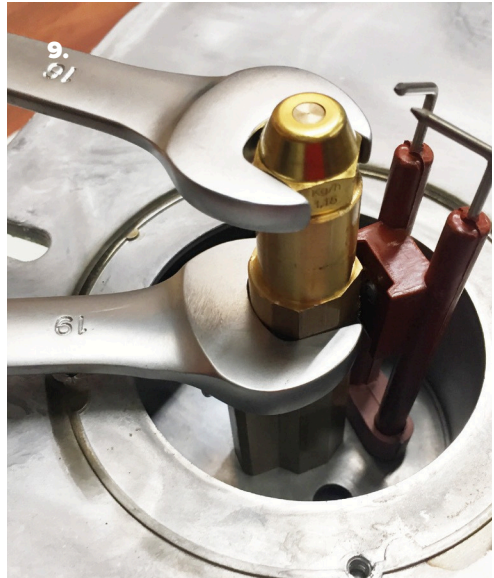
8: Verwijder de nozzle met een 16 mm en 19 mm sleutel.
