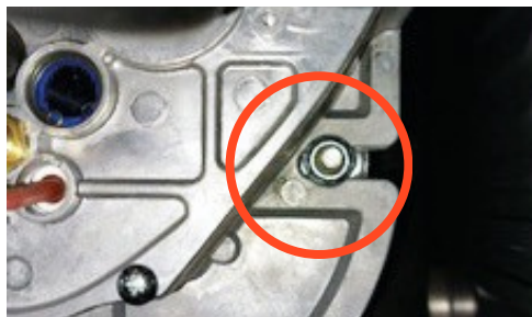
2: Verwijder de bevestigingsmoeren van de brander aan beide zijden (2 stuks).
