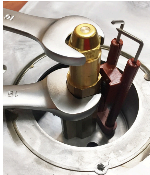
10: Draai de nieuwe nozzle met de vingers op zijn plaats en zet hem tenslotte stevig vast met een steeksleutel.
