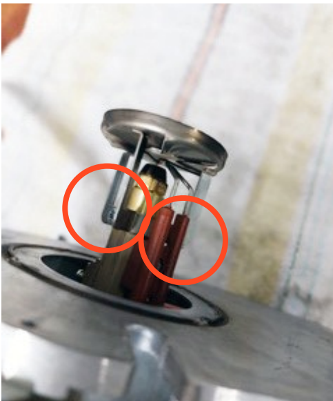
5: Verwijder de nozzledemper op om bij de ontstekingschroef en de schroef van de luchtstroomregelaar te komen.
